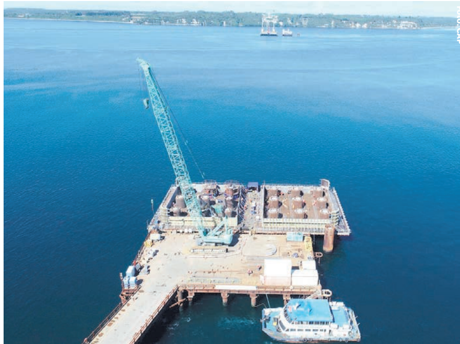
Vista de la construcción de pila norte del Puente Chacao.
